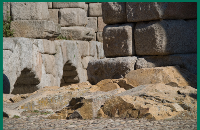
Detalle de los cimientos del Acueducto (granitos rubios) en la Plaza Día Sanz
