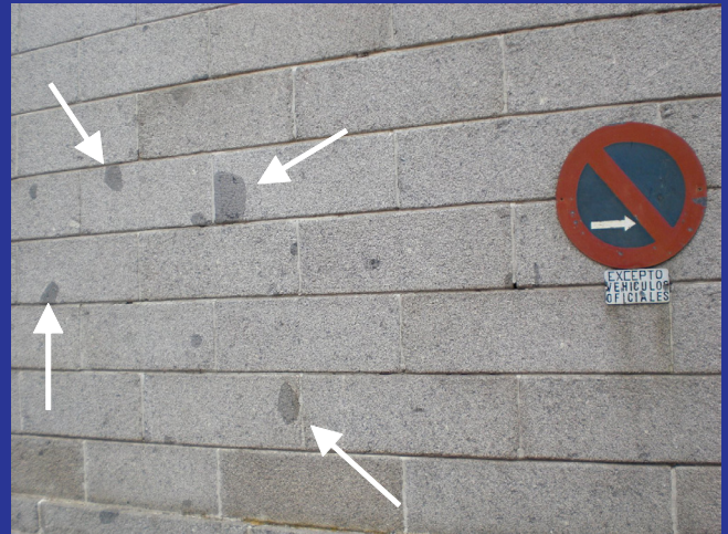
Xenolitos o Gabarros en los sillares de la fachada de la Subdelegación del Gobierno
