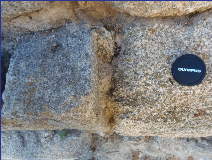
Detalle de los diferentes tipos de granitos en los sillares del Acueducto
