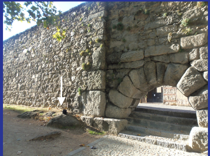
Detalle de los cimientos del Acueducto sobre rocas metamórficas (gneises)
