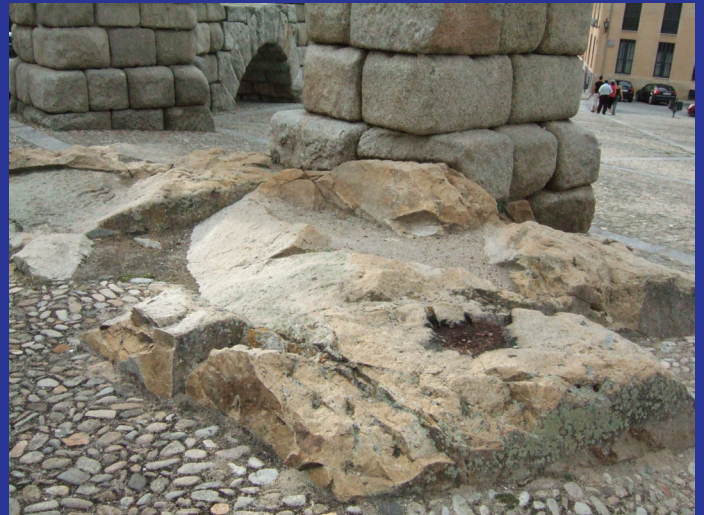
Detalle de los cimientos del Acueducto en la Plaza Día Sanz sobre rocas plutónicas (granitos)
