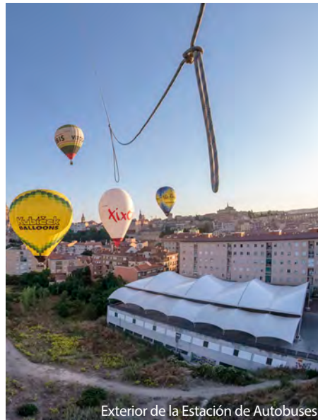
Exterior de la Estación de Autobuses
